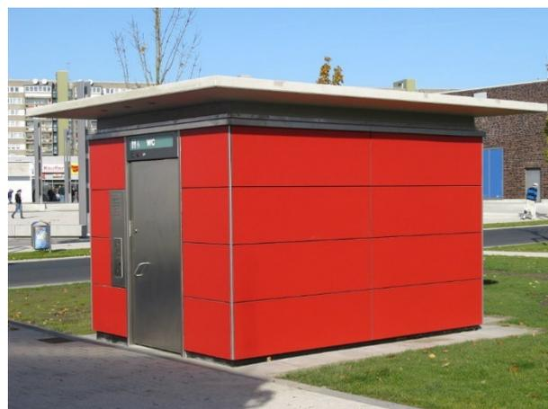
**Abbildung 2** Hering Sanikonzept CWC-Anlage R 110 B mit HPL-TrespaMeteon®-Fassadenverkleidung
