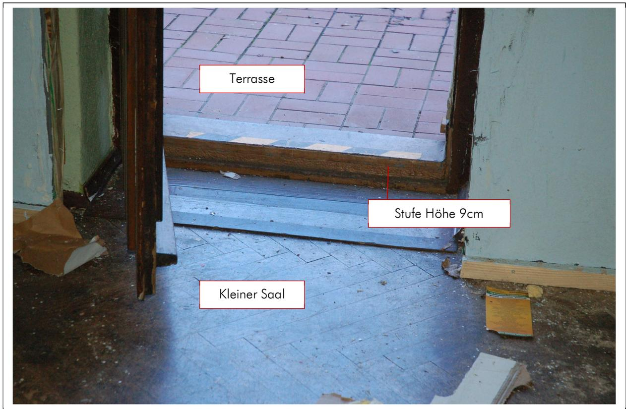
Die Sanierung der Terrasse umfasst den vorherigen vollständigen Abbruch der gesamten Deckenkonstruktion mit anschließendem Einbau einer Handverlegedecke (in der Fläche ca. 30cm tiefer als die bestehende Decke) mit dem Einbau von Dämmung, Abdichtung einschließlich der Wandanschlüsse und der Erneuerung des Bodenbelages sowie der Geländerkonstruktion.
