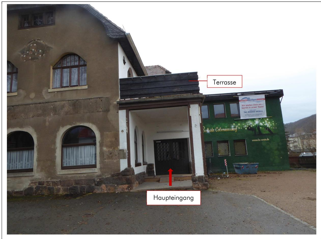
Am Ausgang zur Terrasse befindet sich eine holzverkleidete Stufe mit einer Höhe von ca. 9cm nach oben, welche eine Stolpergefahr darstellt, da diese höher als die Oberkante des Fußbodens „Kleiner Saal“ ist, außerdem ist ein Eindringen von Regenwasser nicht sicher zu verhindern. Im Innern ist das Parkett bereits aufgewölbt, was auf das Eindringen von Regenwasser schließen lässt.
