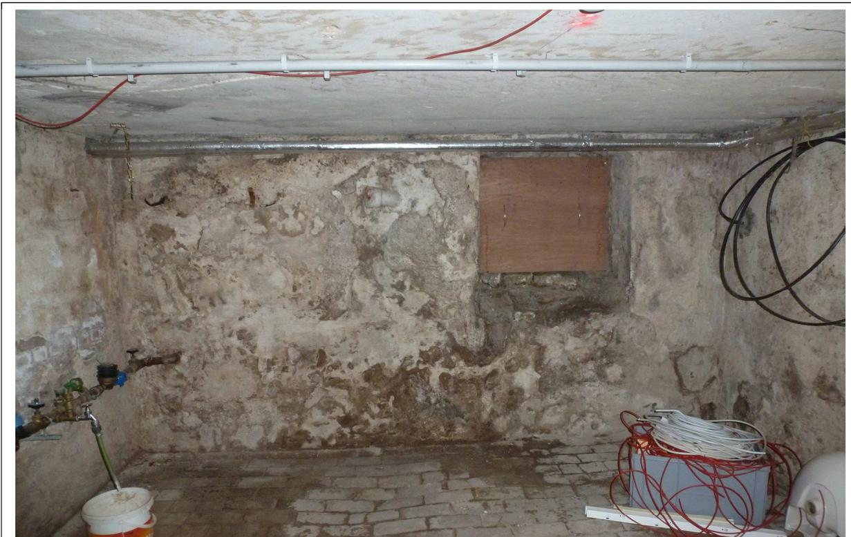
Feuchte Wände im Kellergeschoss – Anschlussraum Trinkwasser Ostseite
