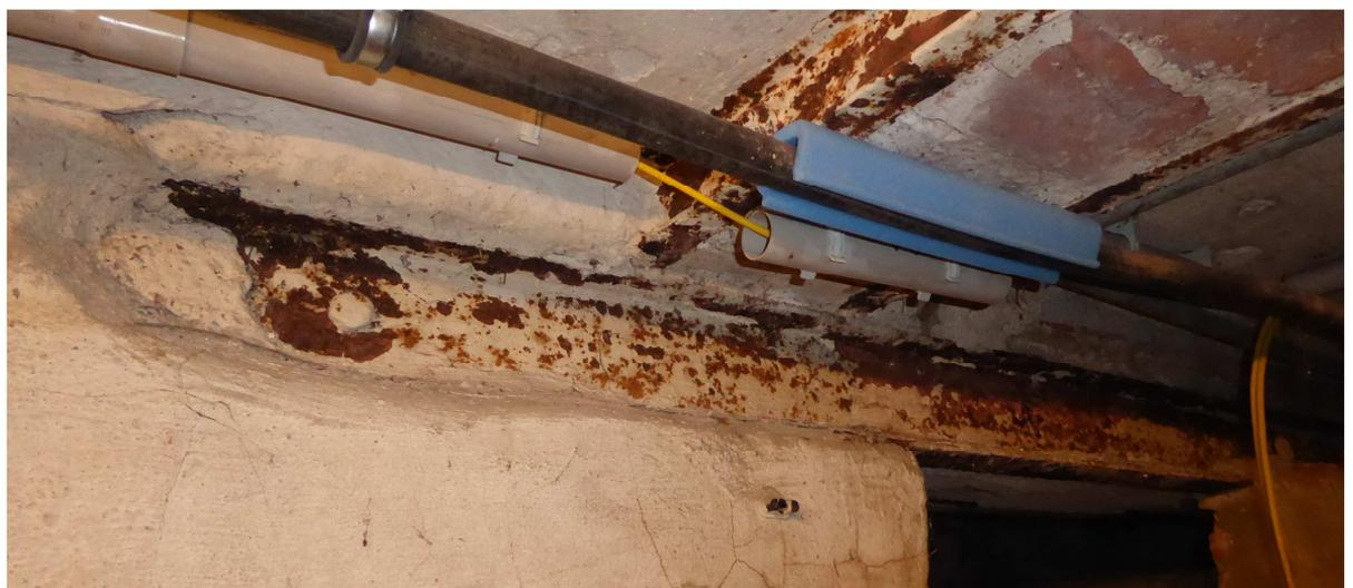
Korrosion der Stahlträger in der Decke im Kellergeschoss = Schädigung tragender Bauteile durch Feuchtigkeit – hier Flurbereich zum Treppenhaus 2
