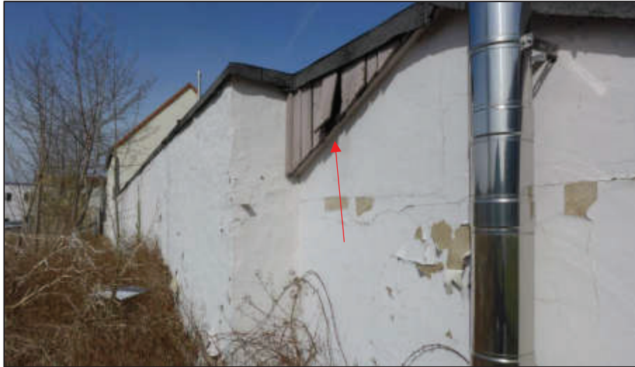
Foto 7: Abstehende Holzverschalung am Gebäude (siehe roter Pfeil) ermöglicht den Zugang für geschützte Arten wie Fledermäuse
