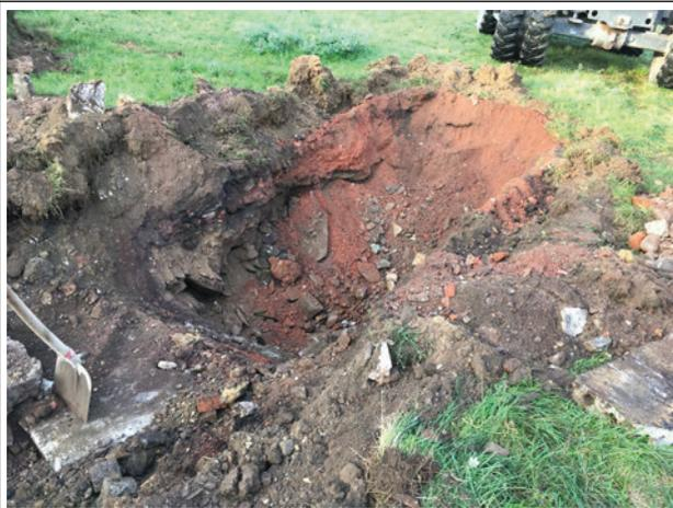
Schurf 2 wurde seitlich verlagert, da im ersten Ansatz ein altes Fundament und großblockige Bauschuttstücke angetroffen wurden.
