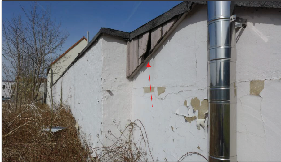
Foto 7: Absteigende Holzverschalung am Gebäude (siehe roter Pfeil) ermöglicht den Zugang für geschützte Arten wie Fledermäuse
