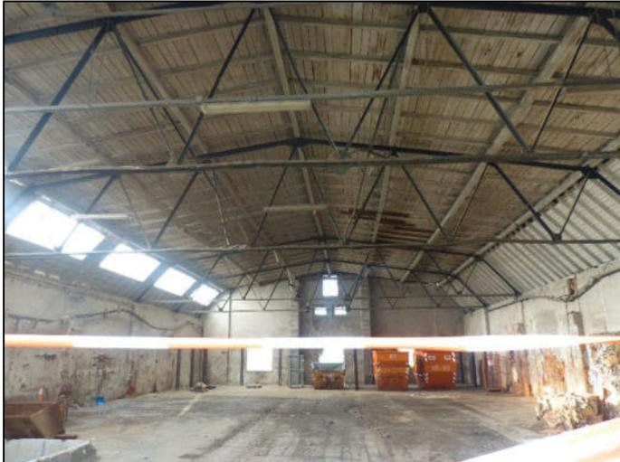
Foto 10: Kleine Lagerhalle - Holzverschalung im Deckenbereich
