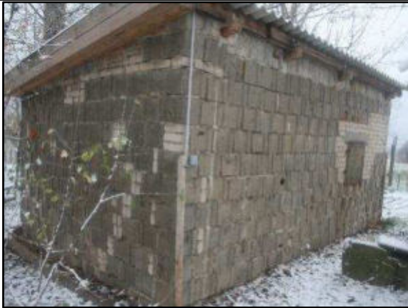
Foto 49: Blick von Nordosten auf Gebäude 8 (Entenstall)
