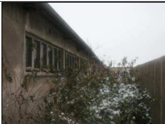
Foto 13: Blick auf die Nordwestseite des Gebäudes 3 (Stall) mit vorgelagertem Brombeeraufwuchs
