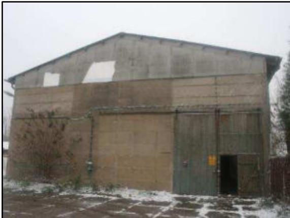
Foto 1: Blick auf Gebäude 1 (Lagerhalle) von Norden
