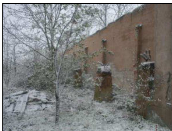
Foto 76: potentielles Reptilienhabitat östlich der Restmauer (Gebäude 11)
