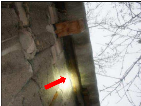
Foto 51: potentielles Spaltenquartier hinter Dachverbreiterung (roter Pfeil) an südwestlicher Außenmauer von Gebäude 8 (Entenstall)
