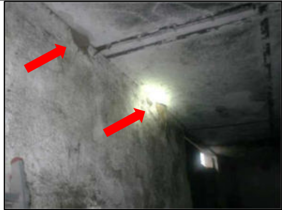
Foto 20: 2 Nester der Rauchschwalbe (rote Pfeile) im Inneren des Gebäudes 3 (Stall)
