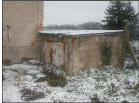
Foto 38: Blick von Osten auf das Kadaverhäuschen (Gebäude 5)
