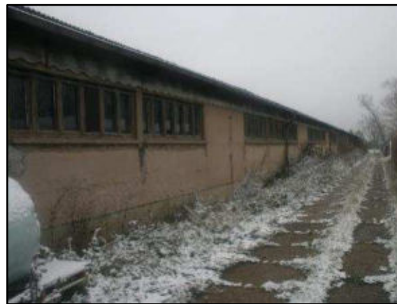
Foto 28: Südwestseite des Gebäudes 4 (Stall)
