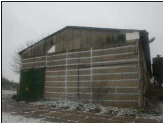
Foto 3: Blick auf den Südwestgiebel von Gebäude 1 (Lagerhalle)
