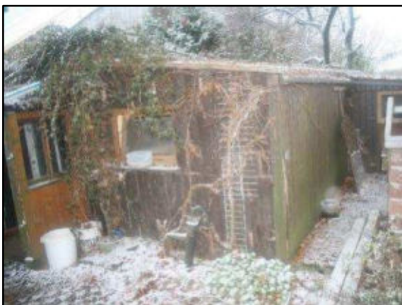
Foto 47: Blick auf die Nordostseite der Schuppen (Gebäude 7)
