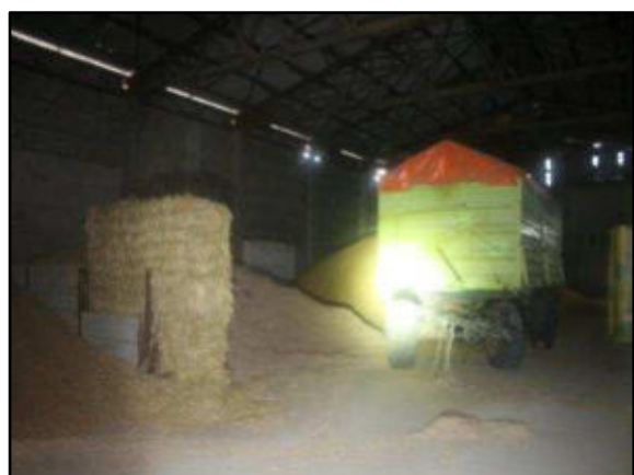
Foto 6: Blick in das Innere von Gebäude 1 (Lagerhalle)
