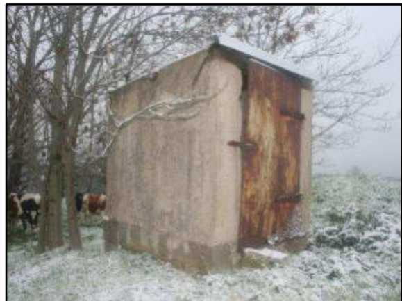
Foto 58: Blick von Südwesten auf Gebäude 10 (Wasserhäuschen)
