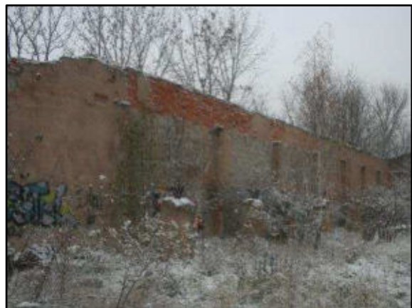
Foto 60: Blick von Süden auf Restmauer (Gebäude 11)
