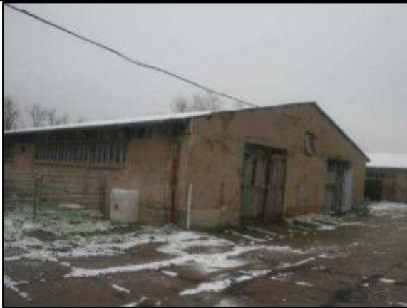
Foto 25: Ansicht auf den nordwestlichen Teil des Gebäudes 4 (Stall) von Norden
