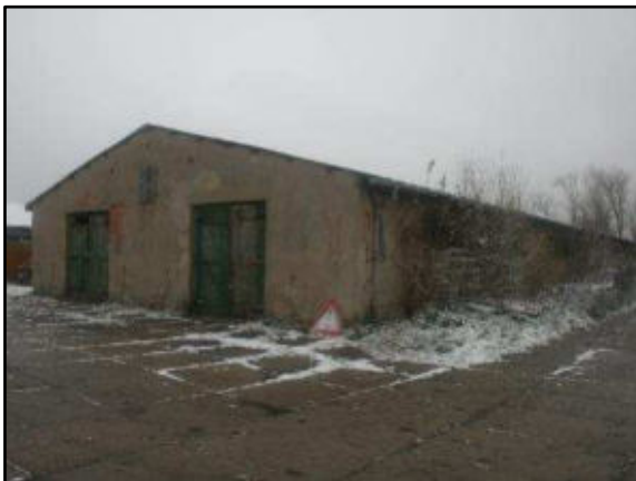
Foto 11: Blick von Südwesten auf das Gebäude 3 (Stall)
