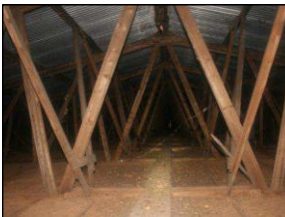
Foto 18: Blick von Südosten in den Dachboden des Gebäudes 3 (Stall)
