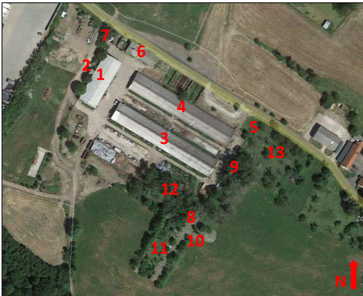
Abbildung 1: Lage und Nummerierung der untersuchten Gebäude und Gehölzabschnitte (rote Zahlen 1 bis 13) im Plangebiet (Quelle: Google Earth)
