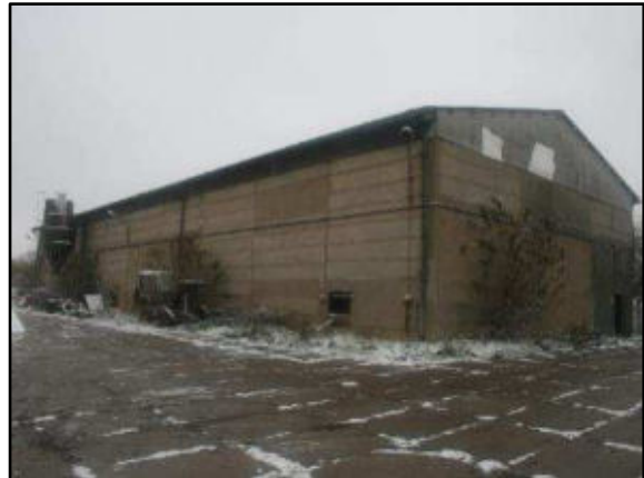
Foto 2: Blick von Nordosten auf das Gebäudes 1 (Lagerhalle)
