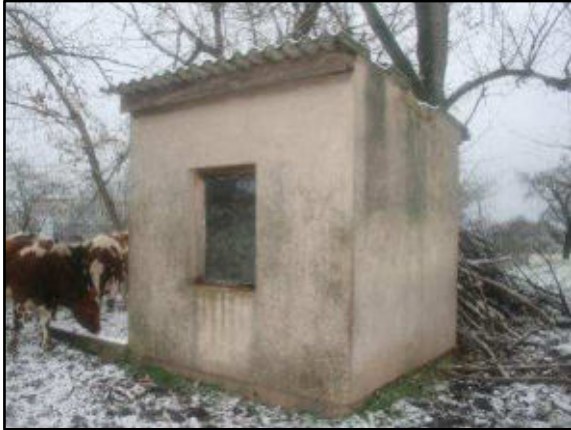
Foto 55: Blick von Südwesten auf Gebäude 9 (Pumpenhaus)
