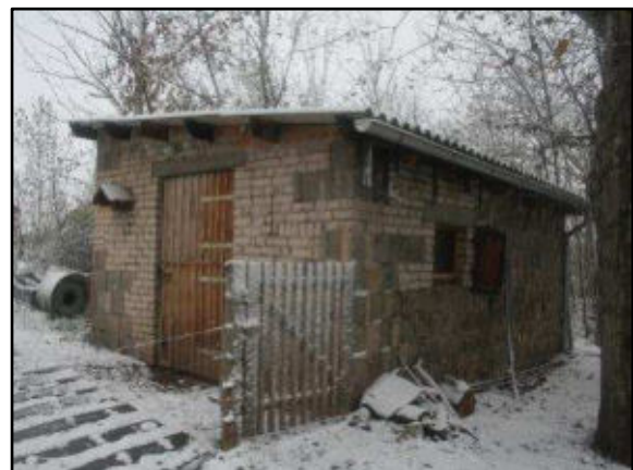
Foto 48: Blick von Nordosten auf Gebäude 8 (Entenstall)
