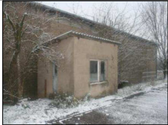
Foto 8: Blick von Nordwesten auf das Gebäude 2 (Waagehaus), dahinter Nordwestseite des Gebäude 1 (Lagerhalle)
