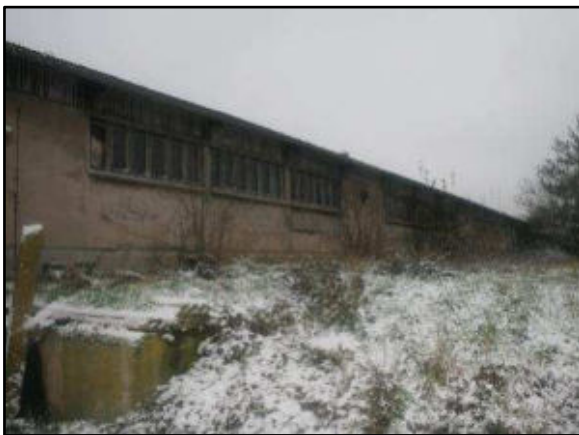
Foto 27: östlicher Teil der Nordostseite des Gebäudes 4 (Stall)
