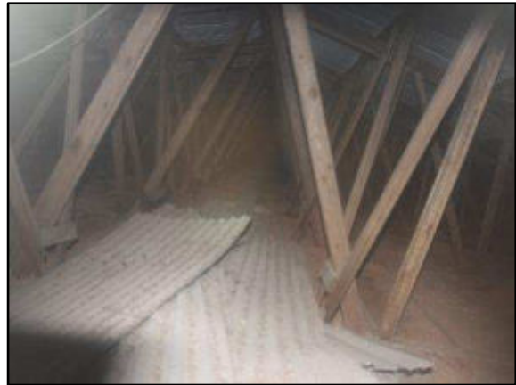
Foto 34: Blick von Nordwesten in den Dachboden des Gebäudes 4 (Stall) durch eine Türöffnung
