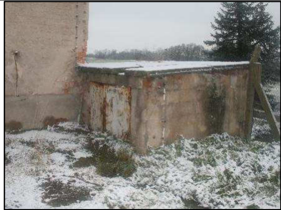
Foto 38: Blick von Osten auf das Kadaverhäuschen (Gebäude 5)
