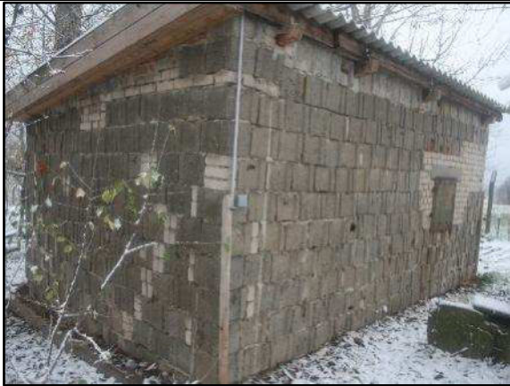
Foto 49: Blick von Nordosten auf Gebäude 8 (Entenstall)
