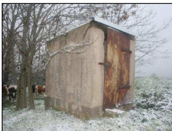
Foto 58: Blick von Südwesten auf Gebäude 10 (Wasserhäuschen)
