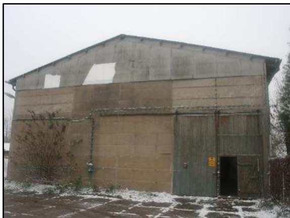
Foto 1: Blick auf Gebäude 1 (Lagerhalle) von Norden
