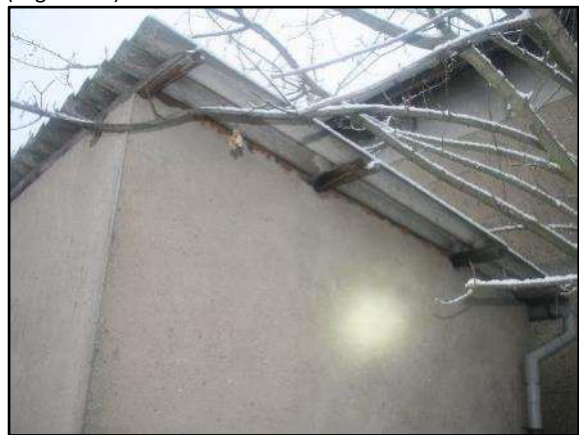
Foto 10: südwestliche Dachseite mit Einschlupfmöglichkeiten für Fledermäuse zwischen Maueroberkante und Asbestverdachung am Waagehaus (Gebäude 2)
