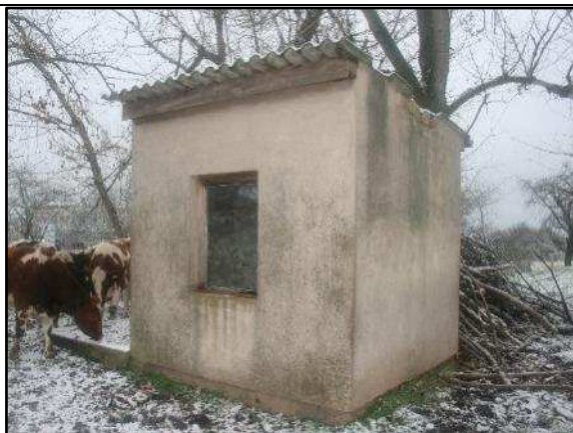
Foto 55: Blick von Südwesten auf Gebäude 9 (Pumpenhaus)
