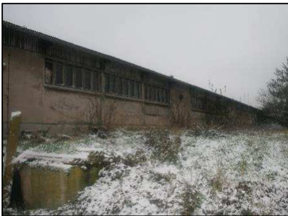
Foto 27: östlicher Teil der Nordostseite des Gebäudes 4 (Stall)
