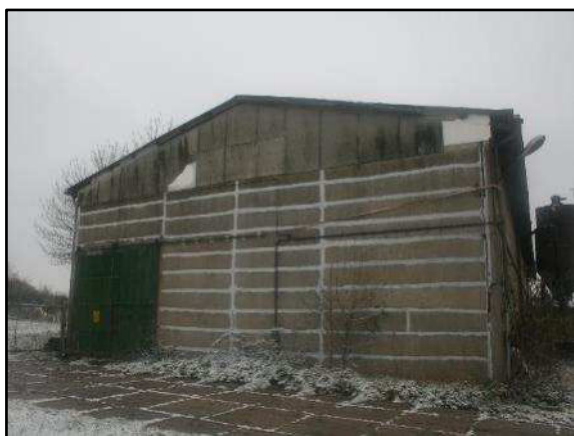
Foto 3: Blick auf den Südwestgiebel von Gebäude 1 (Lagerhalle)
