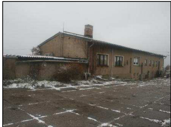
Foto 40: Blick von Süden auf die Südwestseite des Gebäudes 6 (Wohnhaus)
