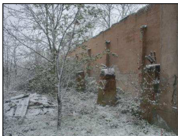
Foto 76: potentielles Reptilienhabitat östlich der Restmauer (Gebäude 11)
