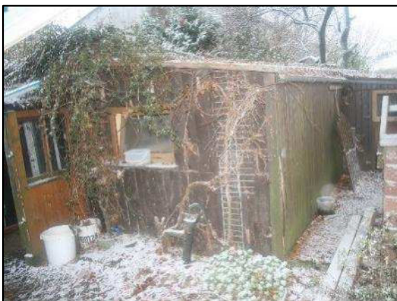
Foto 47: Blick auf die Nordostseite der Schuppen (Gebäude 7)
