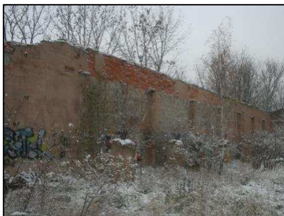
Foto 60: Blick von Süden auf Restmauer (Gebäude 11)
