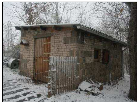
Foto 48: Blick von Nordosten auf Gebäude 8 (Entenstall)
