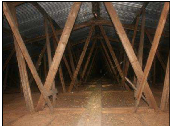
Foto 18: Blick von Südosten in den Dachboden des Gebäudes 3 (Stall)
