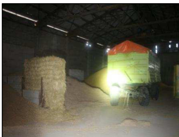
Foto 6: Blick in das Innere von Gebäude 1 (Lagerhalle)
