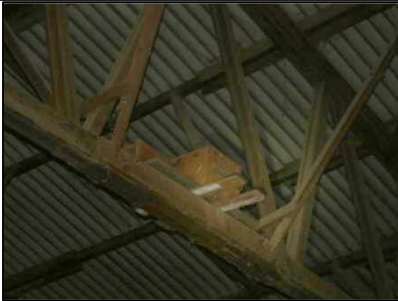
Foto 7: Schleiereulennistkasten auf Dachbalken im Inneren des Gebäudes 1 (Lagerhalle)
