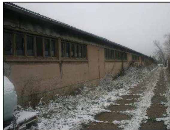
Foto 28: Südwestseite des Gebäudes 4 (Stall)
