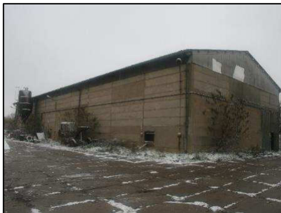
Foto 2: Blick von Nordosten auf das Gebäudes 1 (Lagerhalle)
