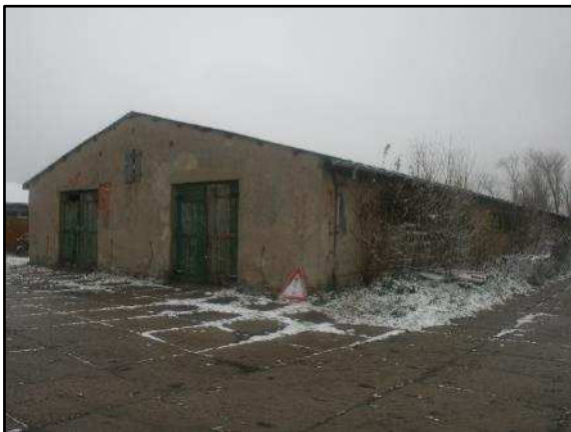
Foto 11: Blick von Südwesten auf das Gebäude 3 (Stall)
