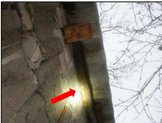
Foto 51: potentielles Spaltenquartier hinter Dachverbreterung (roter Pfeil) an südwestlicher Außenmauer von Gebäude 8 (Entenstall)
