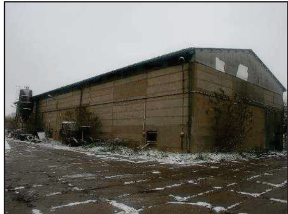
Foto 2: Blick von Nordosten auf das Gebäudes 1 (Lagerhalle)
