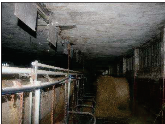
Foto 35: Blick ins Innere des Gebäudes 4 (Stall)
