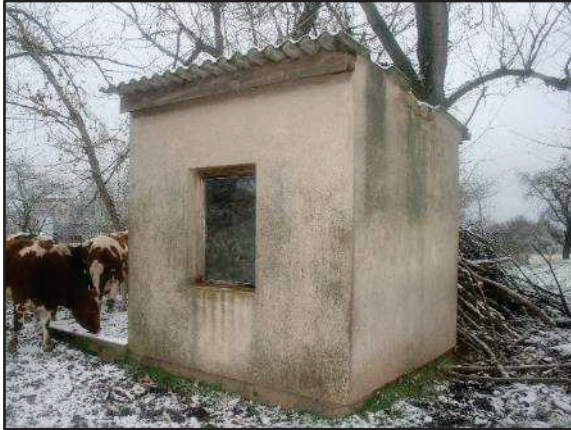
Foto 55: Blick von Südwesten auf Gebäude 9 (Pumpenhaus)
