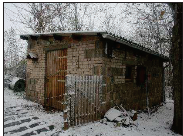
Foto 48: Blick von Nordosten auf Gebäude 8 (Entenstall)
