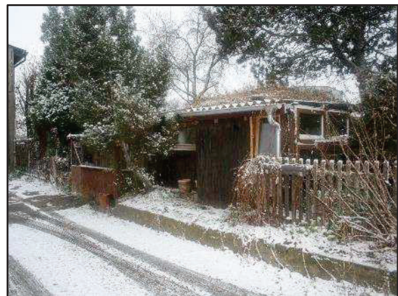
Foto 46: Blick von Nordosten auf die Südostseite der Schuppen (Gebäude 7)
