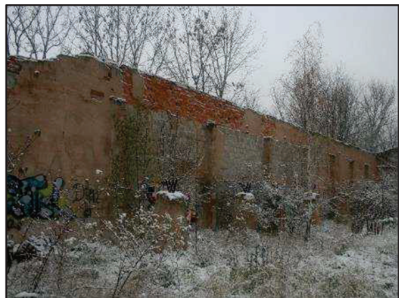
Foto 60: Blick von Süden auf Restmauer (Gebäude 11)
