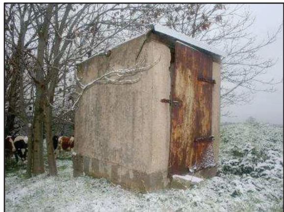
Foto 58: Blick von Südwesten auf Gebäude 10 (Wasserhäuschen)
