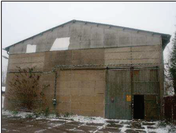
Foto 1: Blick auf Gebäude 1 (Lagerhalle) von Norden
