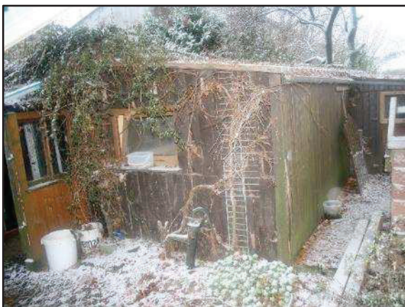
Foto 47: Blick auf die Nordostseite der Schuppen (Gebäude 7)
