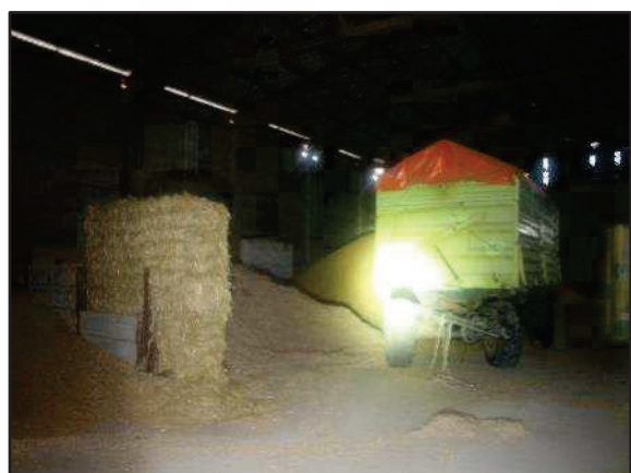
Foto 6: Blick in das Innere von Gebäude 1 (Lagerhalle)
