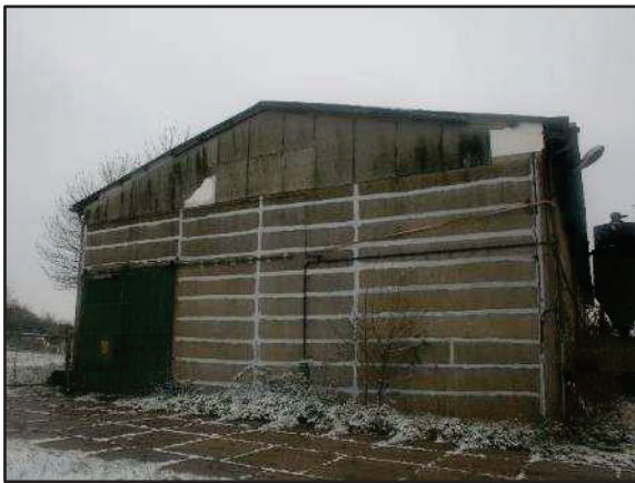
Foto 3: Blick auf den Südwestgiebel von Gebäude 1 (Lagerhalle)
