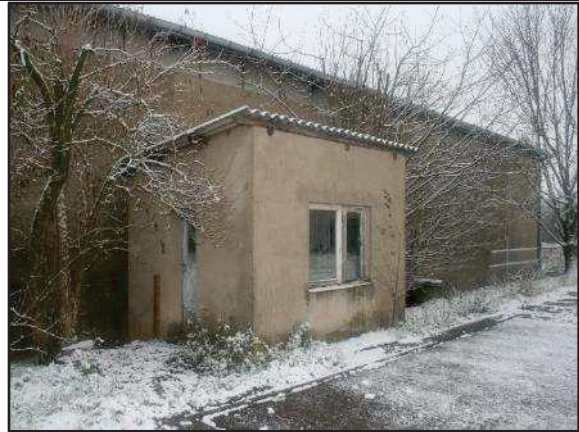
Foto 8: Blick von Nordwesten auf das Gebäude 2 (Waagehaus), dahinter Nordwestseite des Gebäudes 1 (Lagerhalle)
