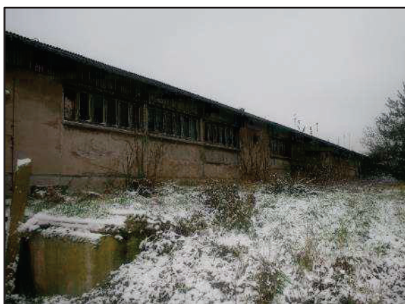
Foto 27: östlicher Teil der Nordostseite des Gebäudes 4 (Stall)
