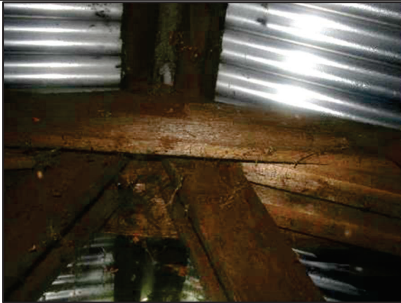
Foto 19: beispielhafter Ausschnitt der oberen Dachkonstruktion im Gebäude 3 (Stall)
