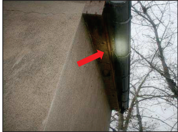
Foto 56: potentielles Spaltenquartier hinter Dachrinne (roter Pfeil) an nordöstlicher Seite von Gebäude 9 (Pumpenhaus)
