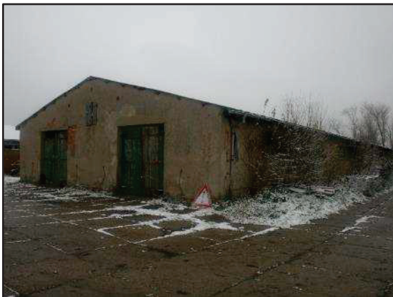
Foto 11: Blick von Südwesten auf das Gebäude 3 (Stall)
