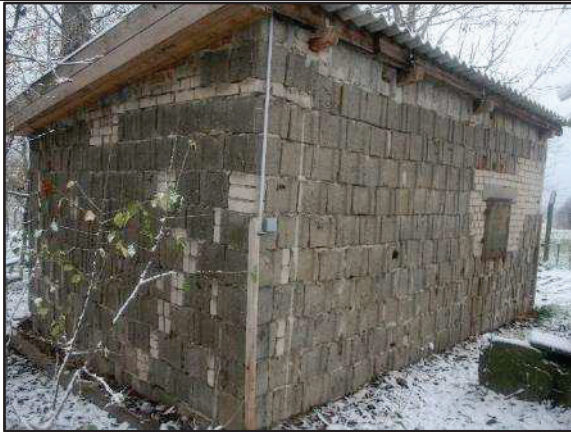
Foto 49: Blick von Nordosten auf Gebäude 8 (Entenstall)
