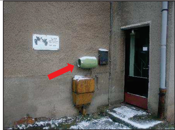
Foto 44: straßenseitiger Eingangsbereich von Gebäude 6 (Wohnhaus) mit Nisthöhle eines Hausrotschwanzes in montierter Milchkanne (roter Pfeil)
