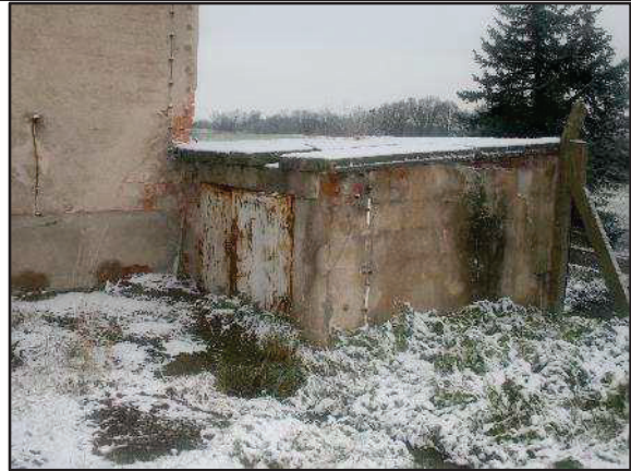
Foto 38: Blick von Osten auf das Kadaverhäuschen (Gebäude 5)
