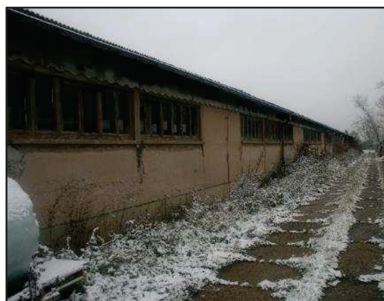
Foto 28: Südwestseite des Gebäudes 4 (Stall)
