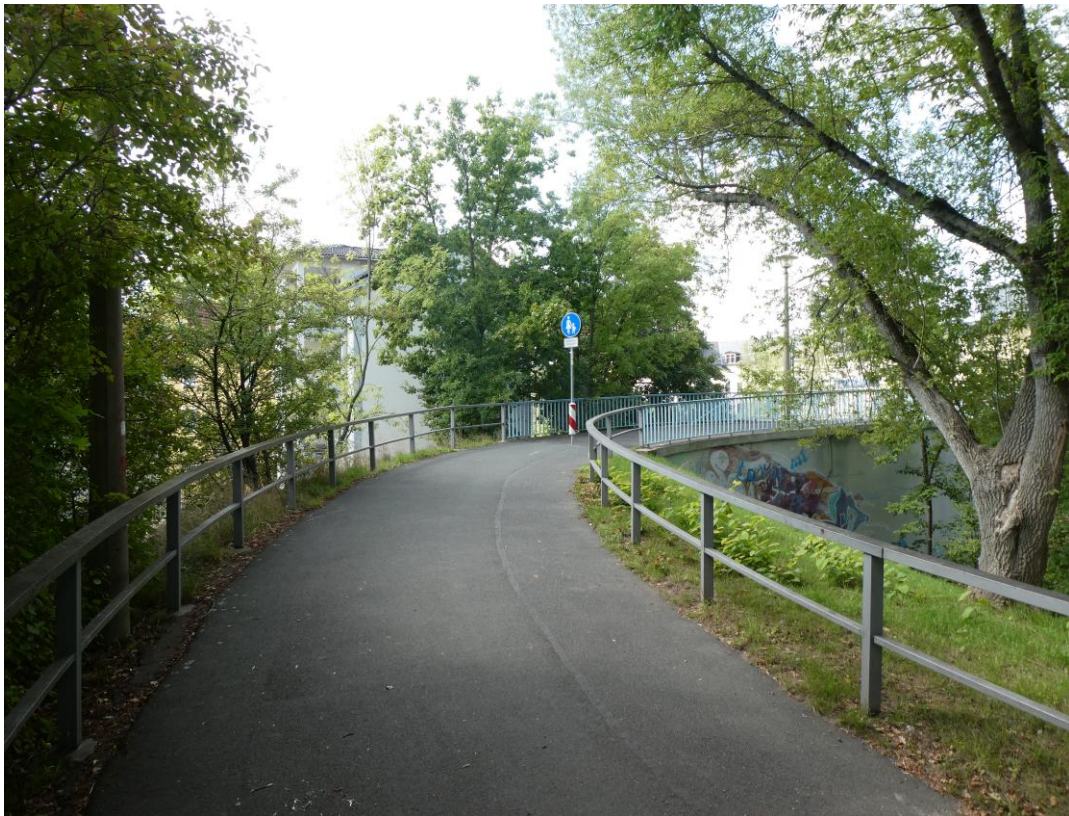
Bild 6: Blick zum Widerlager Südost von Rampe Gutenbergstraße
