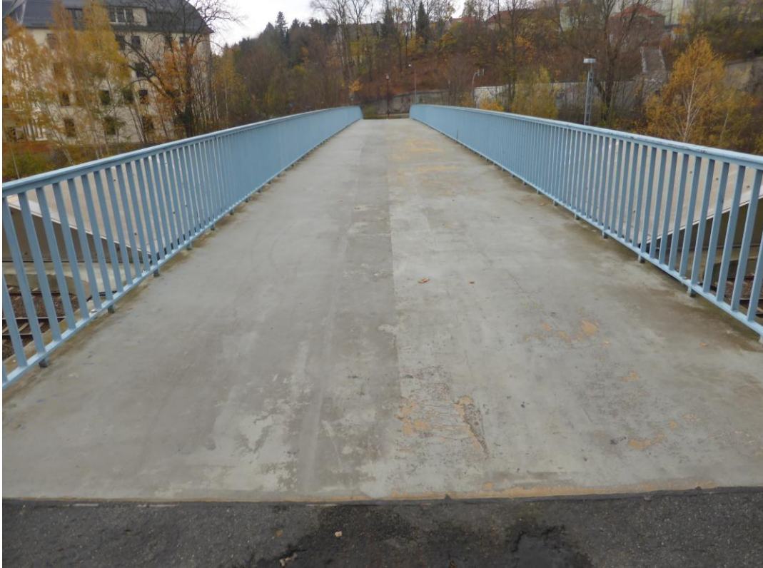
Bild 5: Blick längs Bauwerk nach Nordwest
