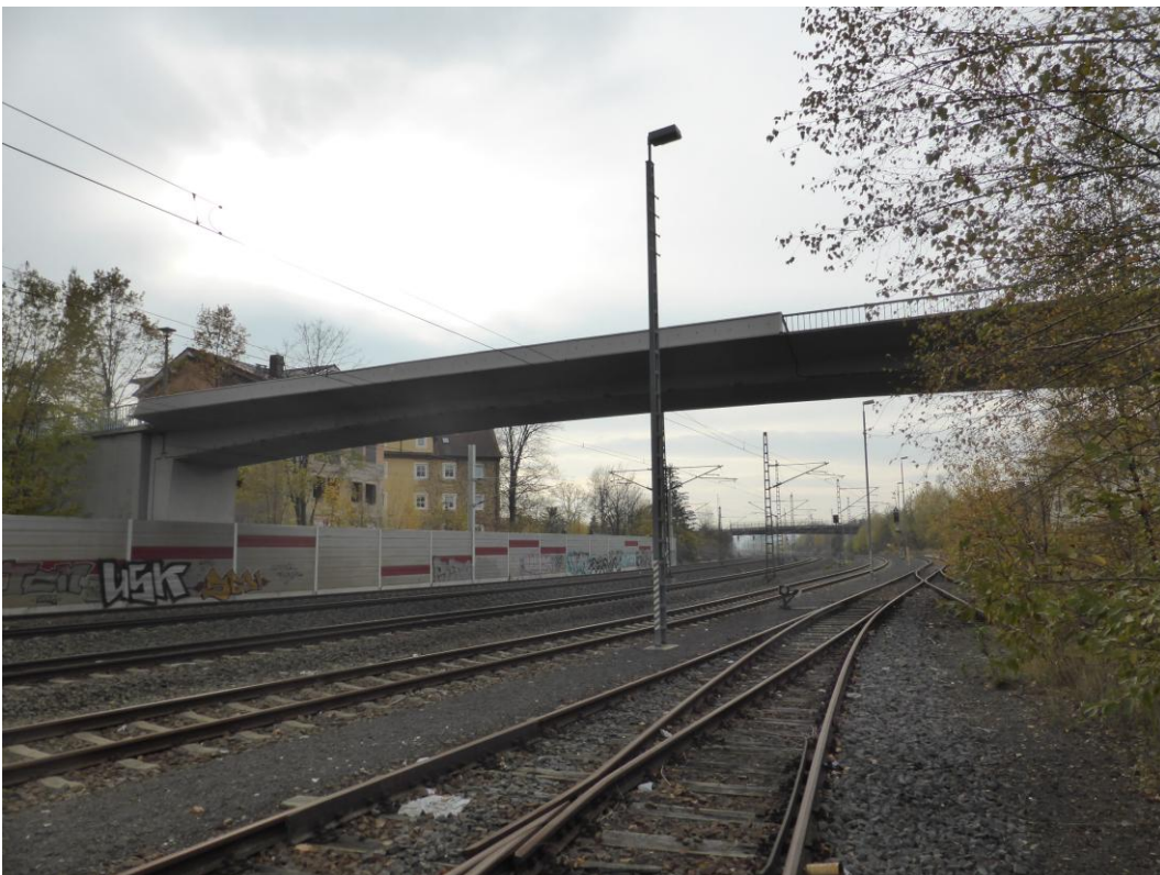
Bild 2: Ansicht von Südwest
