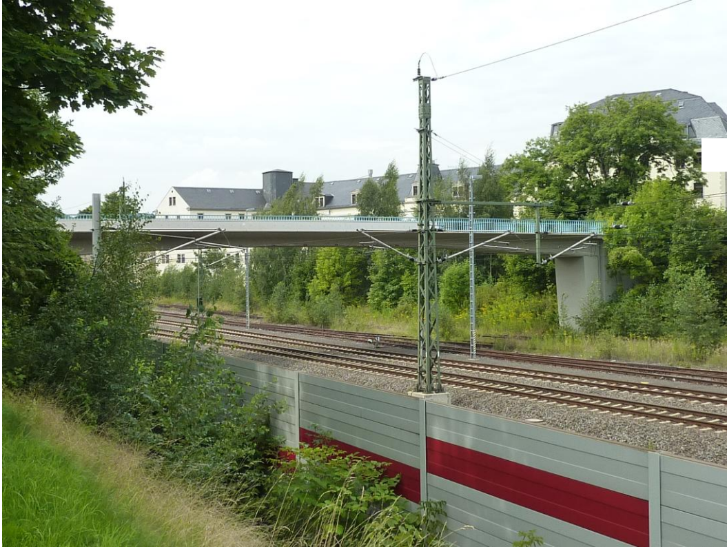
Bild 1: Ansicht von Nordost
